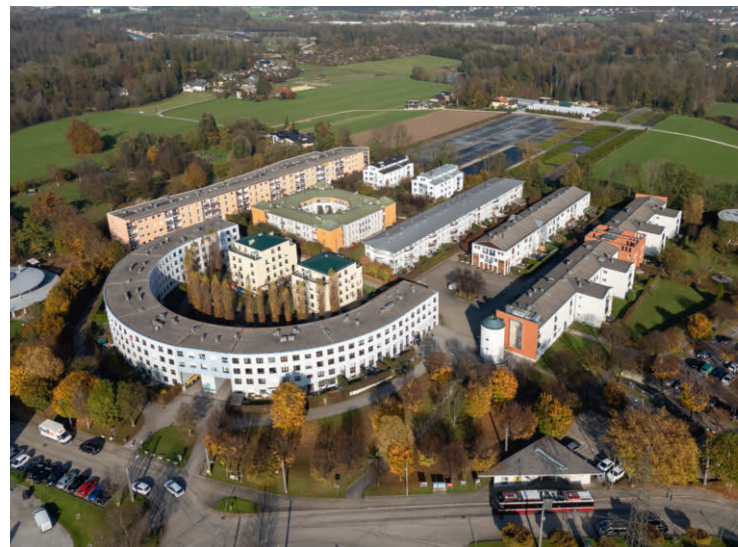
Abb. 1: Salzburg, Forellenwegsiedlung, Oswald Mathias Ungers u. a., 1987–1990, Luftbild 2004
